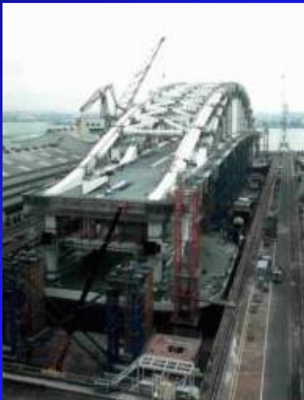
側径間ベント組立
