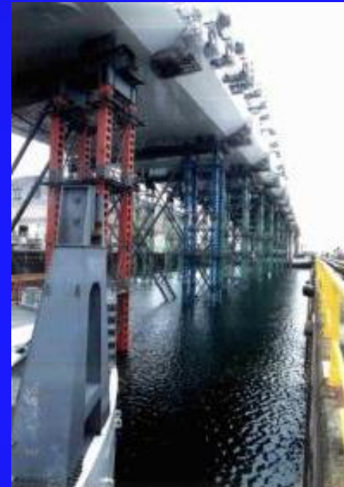
半注水による反力調整
