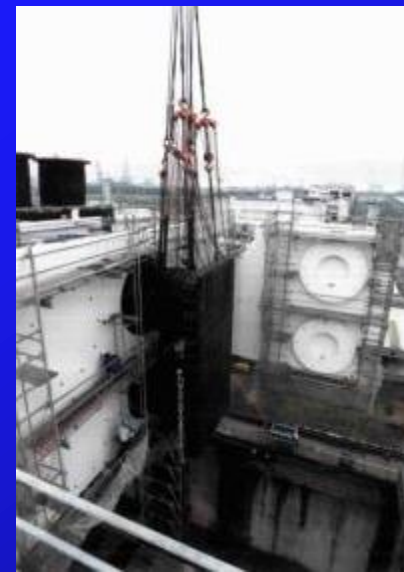
係留フェンダー取付
