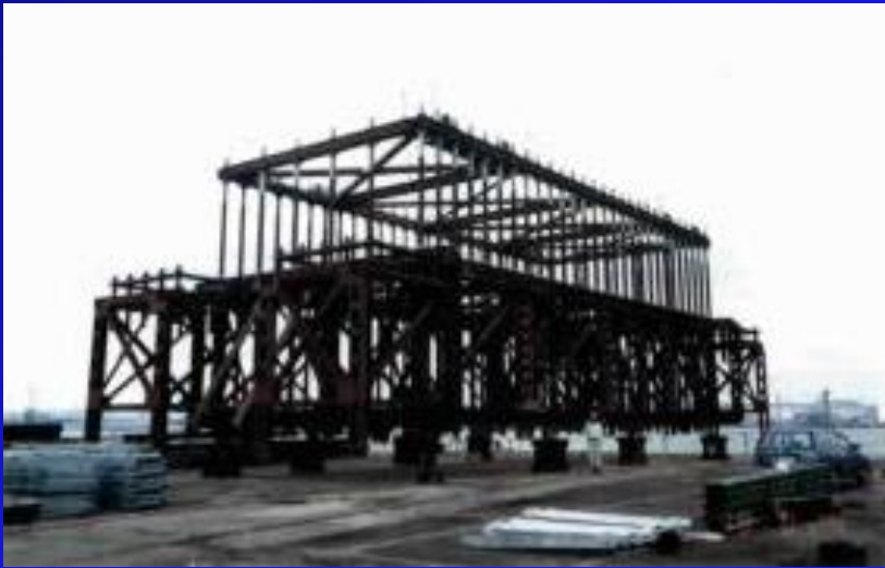
舞洲側アンカーフレーム 総組立完了 (260t)
