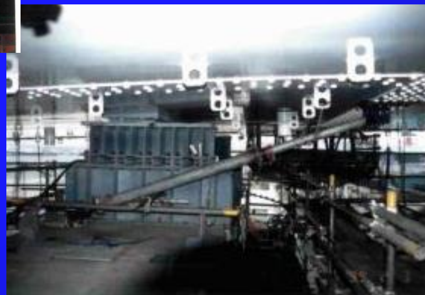
ベント上閉合設備 (ベント変位修正設備と主構受点)
