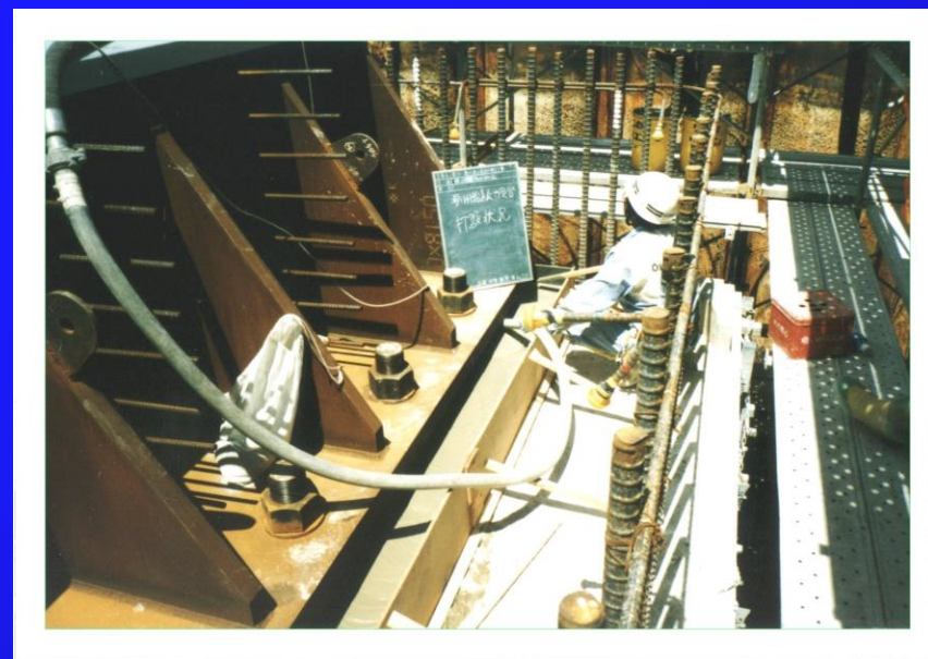
鉛直反力受台グラウト工
