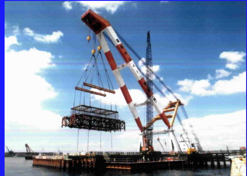
舞洲側アンカーフレーム FC架設
