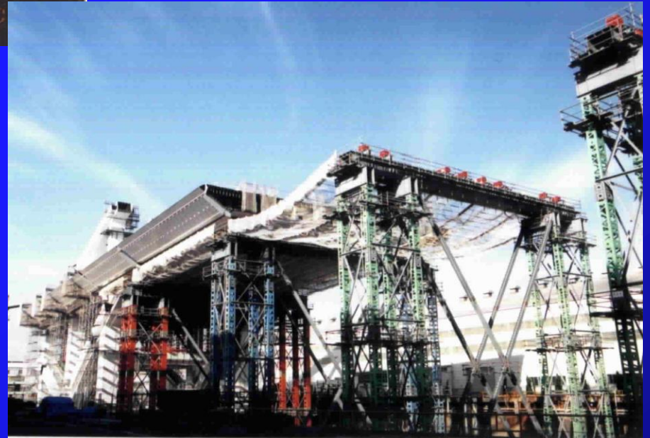
中央径間側補剛桁の架設
