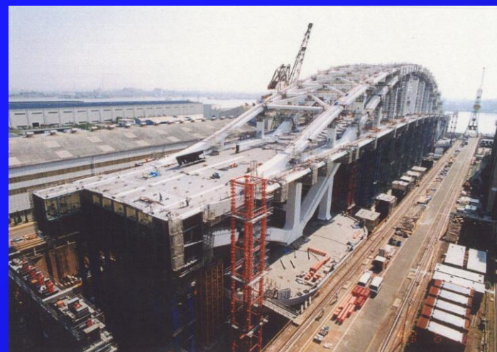
側径間補剛桁架設状況
