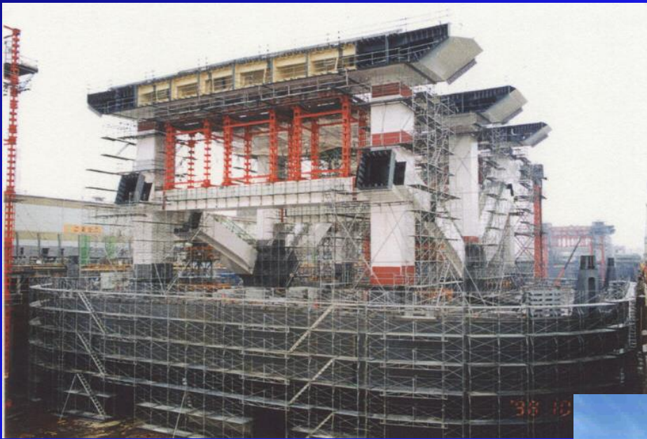
ポンツーン上の架設状況
