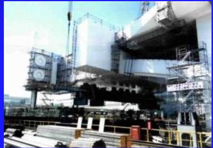
側径間ベント上梁120t ジブ相吊りによる一括撤去
