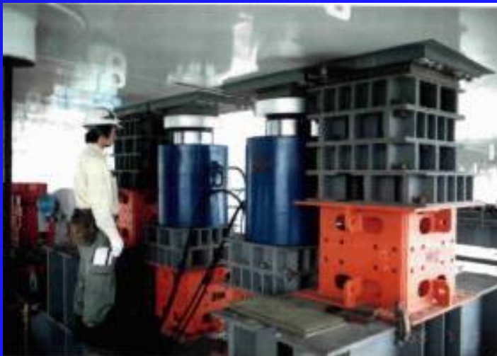
ベント反力解放 1000tジャッキ×2基/片主構)
