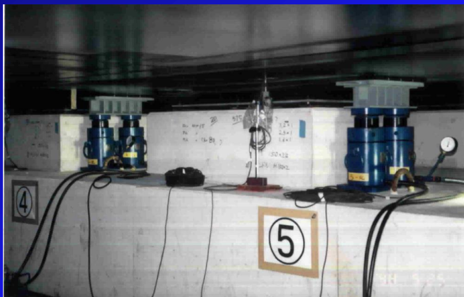
ジャッキアップ状況
