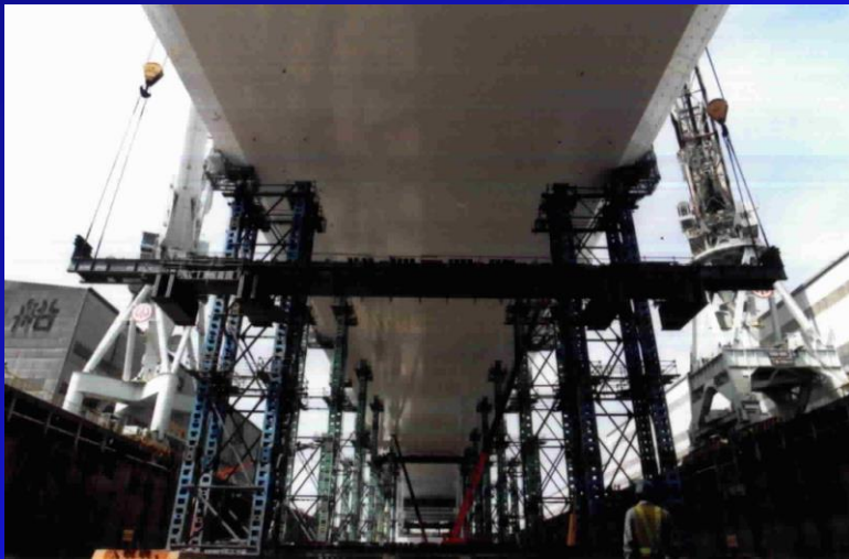
中央径間ベント上梁120t ジブ相吊りによる一括撤去
