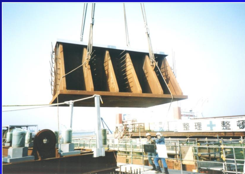
鉛直反力受台架設
