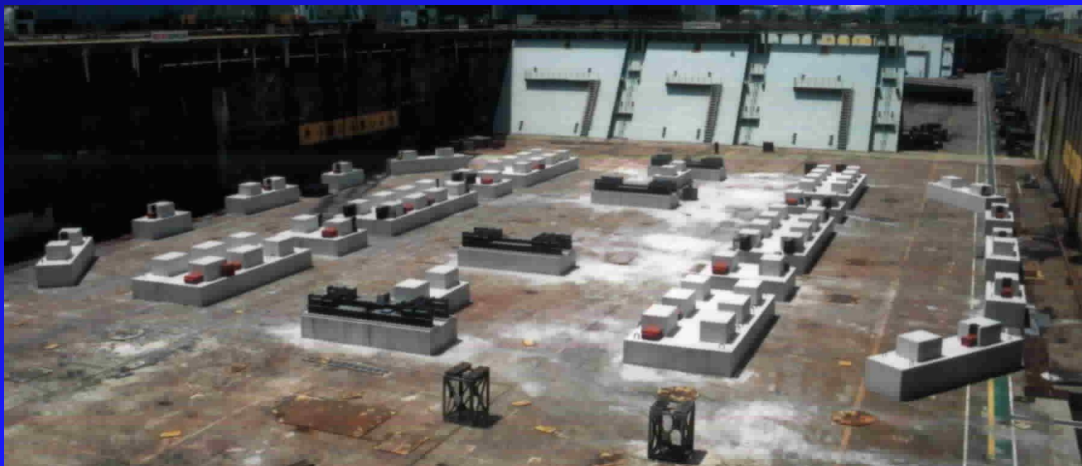
ポンツーン支持架台設置状況
