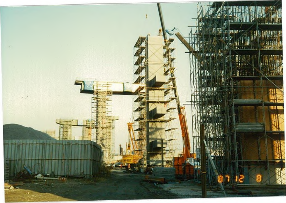
アプローチ橋の橋脚建設が進んでいた・
