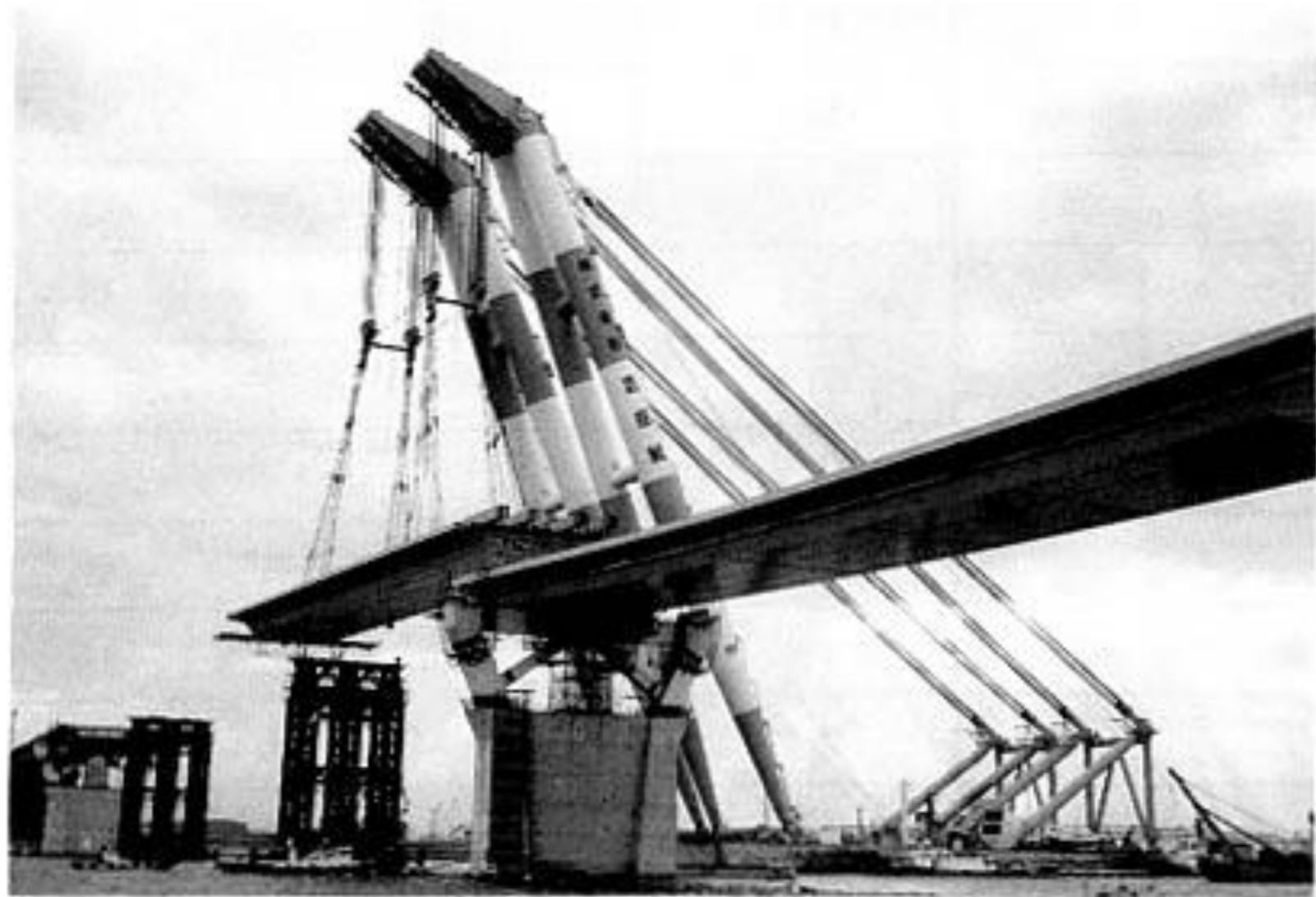
図 13 第4ブロックの架設
