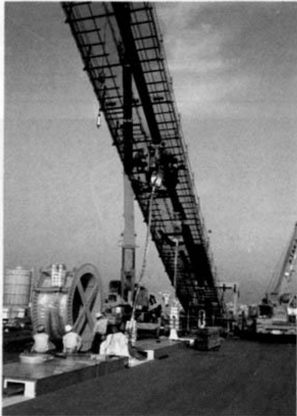
図 24 ハンガーケーブル架設
