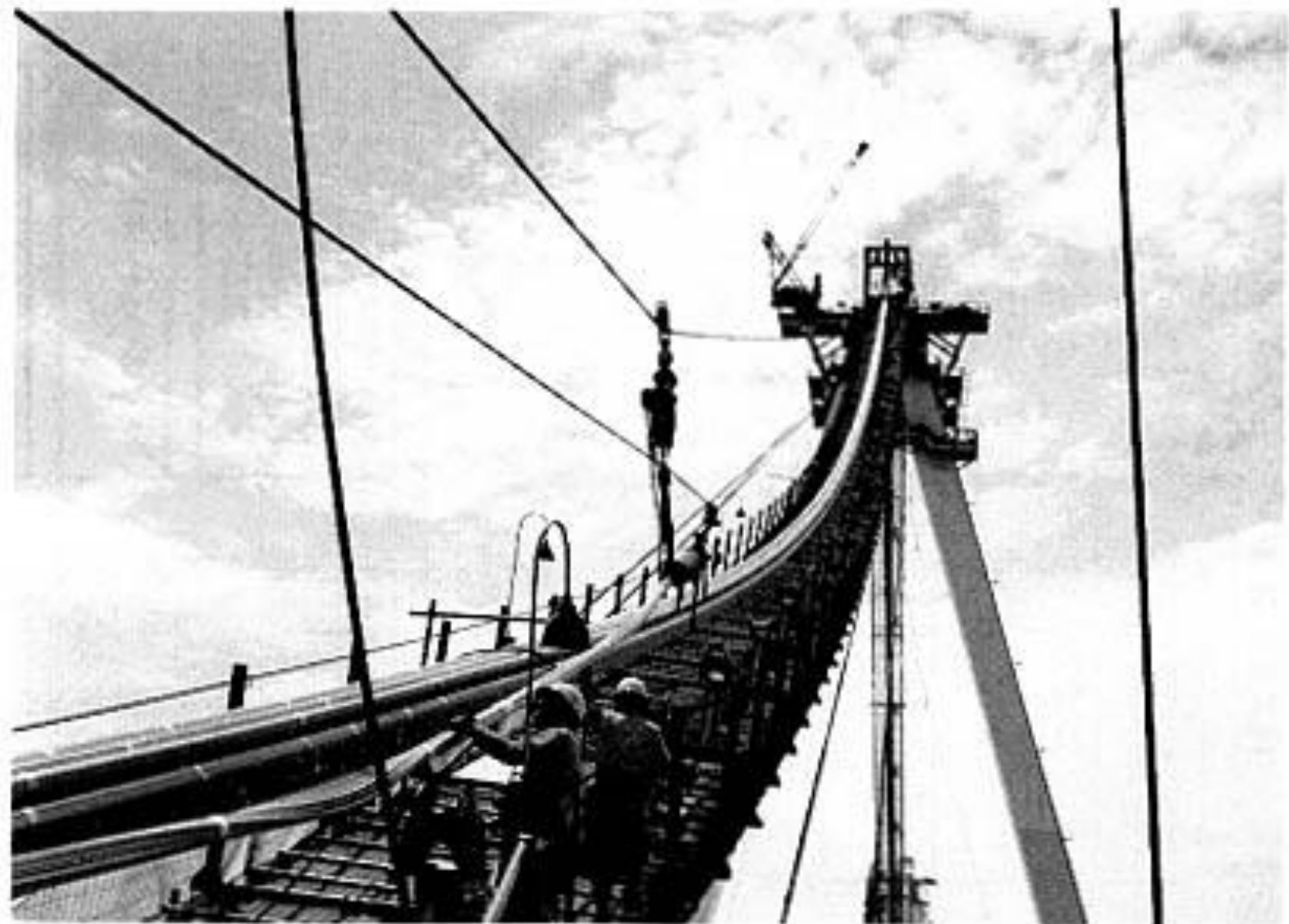
図 16 ストランド架設
