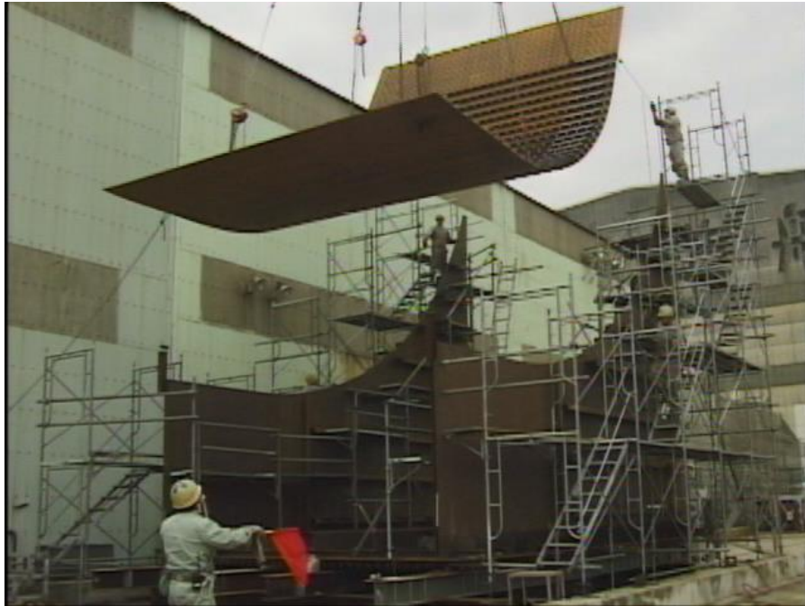
曲面版の据え付け状況
