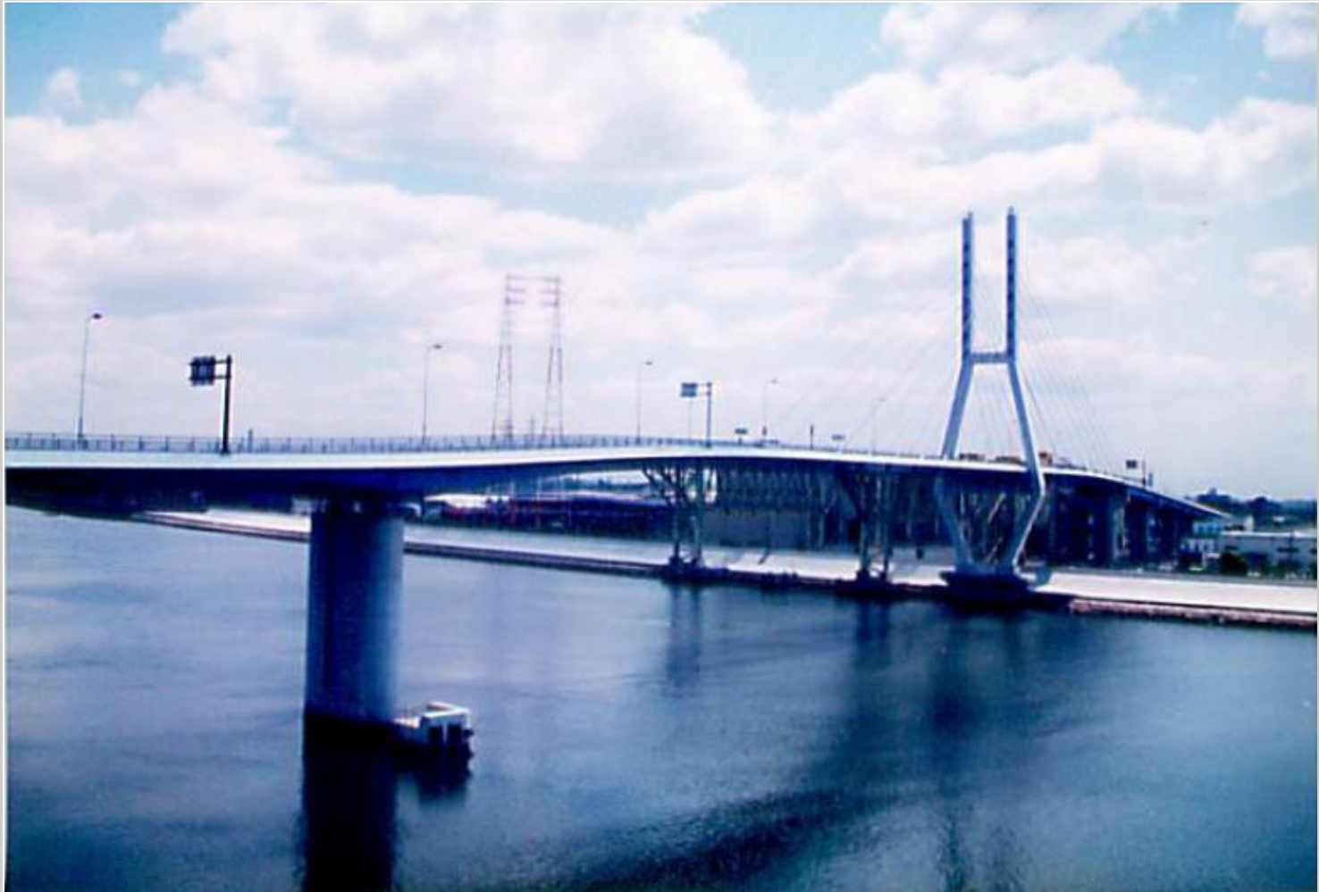
中島新橋の完成写真
