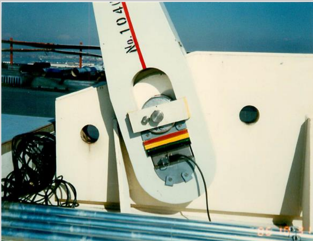
ハンガーケーブルのシムプレート設置写真
