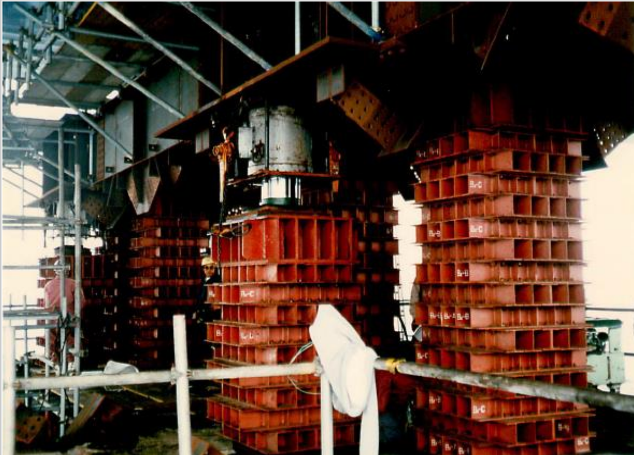
ベント上に設置されたサドルと油圧ジャッキ
