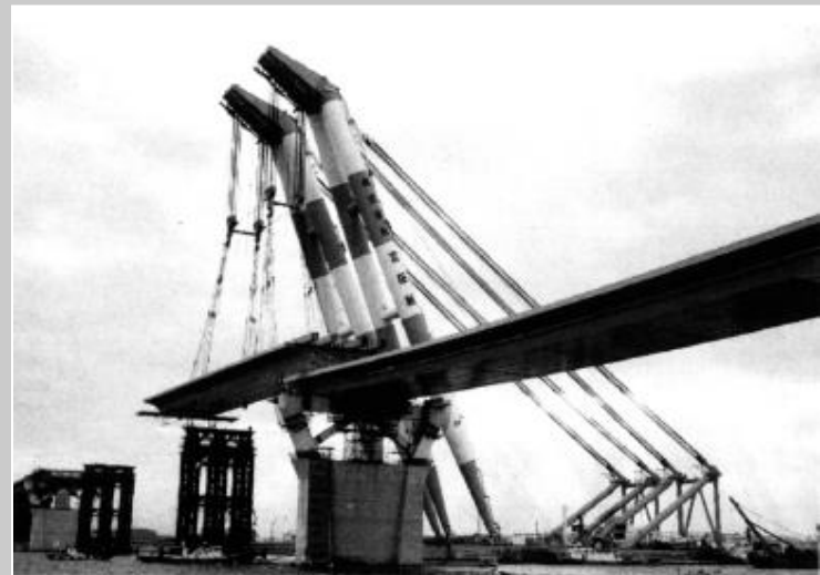
第4ブロック架設
