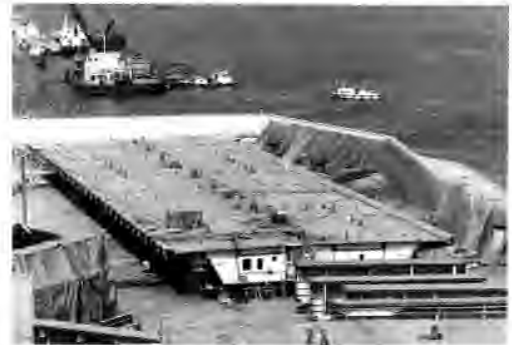
図 5 補剛桁の仮組立
