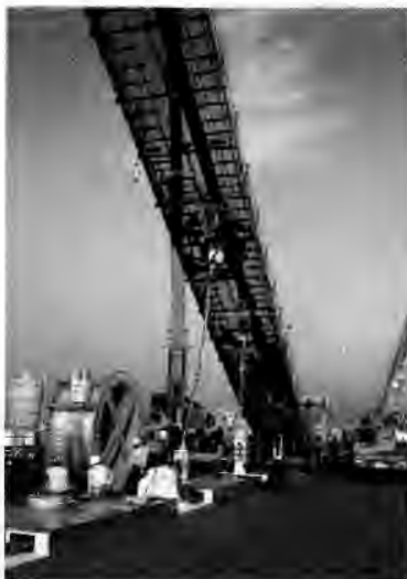
図 24 ハンガーケーブル架設
