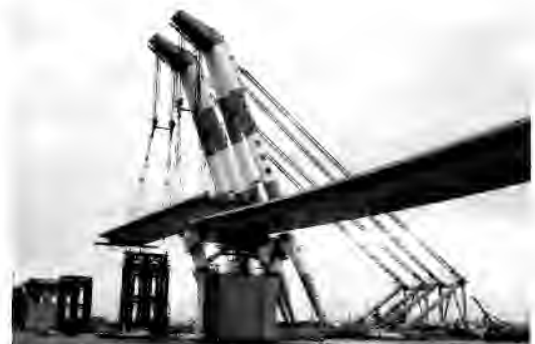
図 13 第4ブロックの架設
