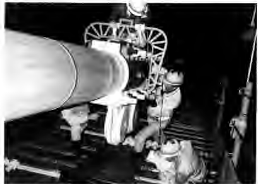
図 22 ボルト軸力計測
