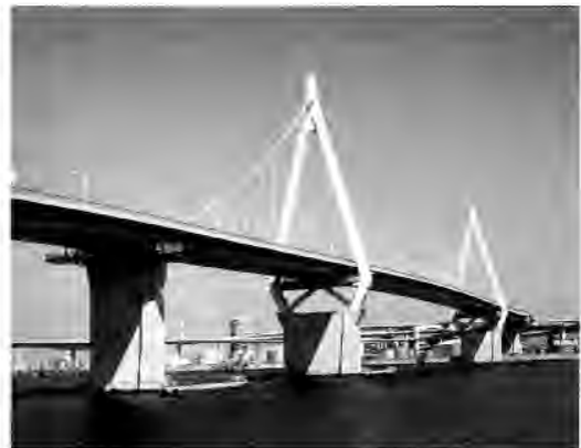
図1 此花大橋主橋梁部
