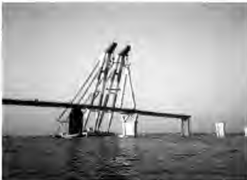
図 11 塔上部の架設
