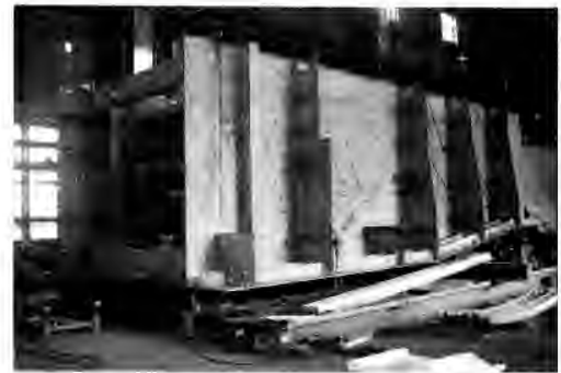
図 4 桁端ケーブル定着ブロックの組立
