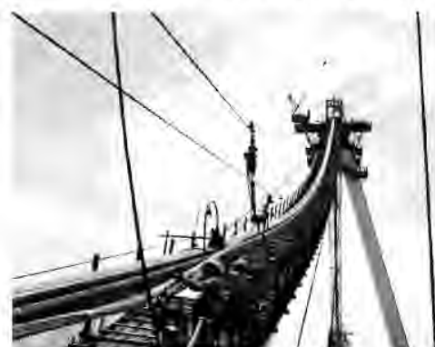
図 16 ストランド架設
